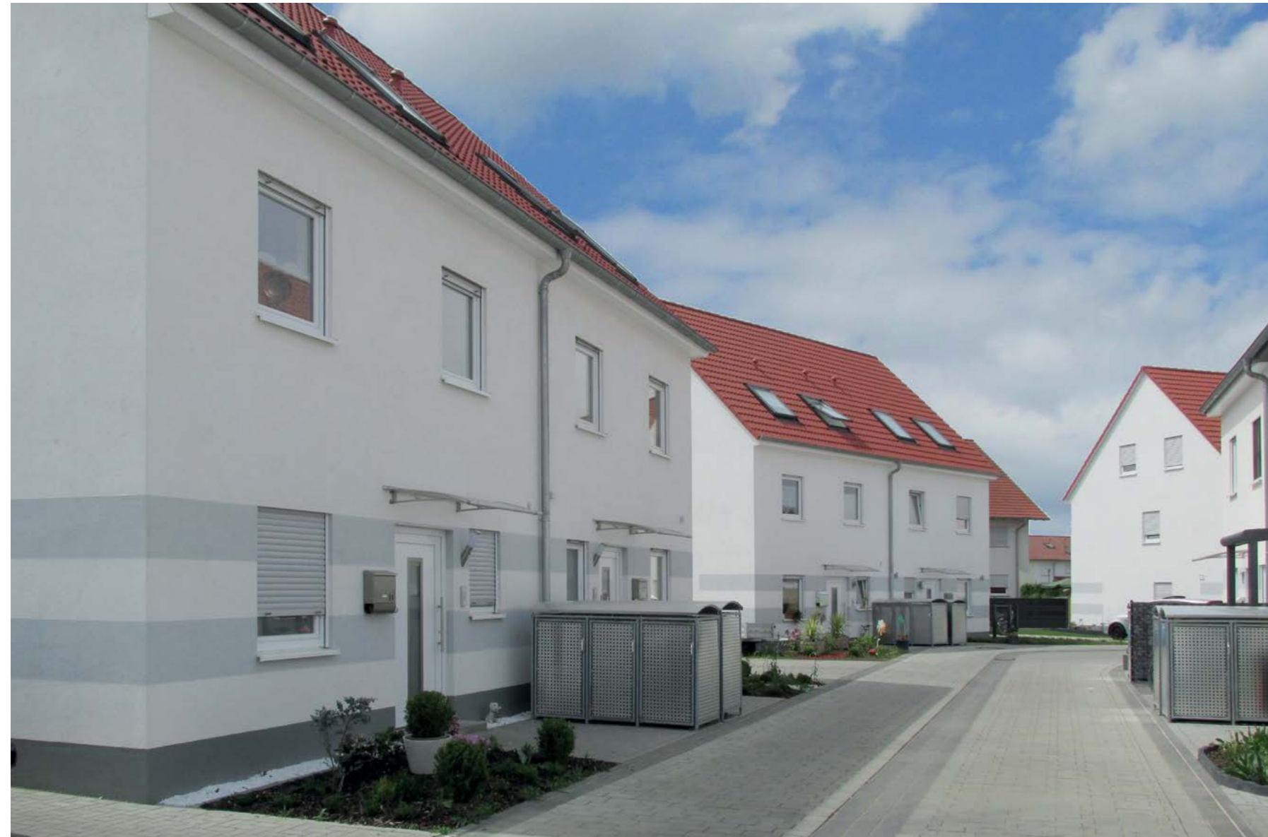
48 Hanau-Großauheim: Erstellung von Einfamilienhäusern als Reihen- und Doppelhäuser
