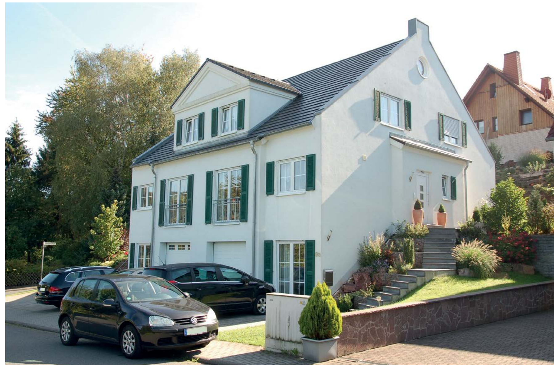
42 Mömbris, „Ascot House“: Erstellung von zwei Doppelhaushälften
