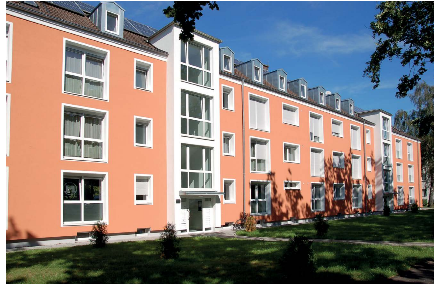
Aschaffenburg: Revitalisierung eines Bestandsgebäudes als Boardinghaus mit Apartments und Gewerbeflächen 47
