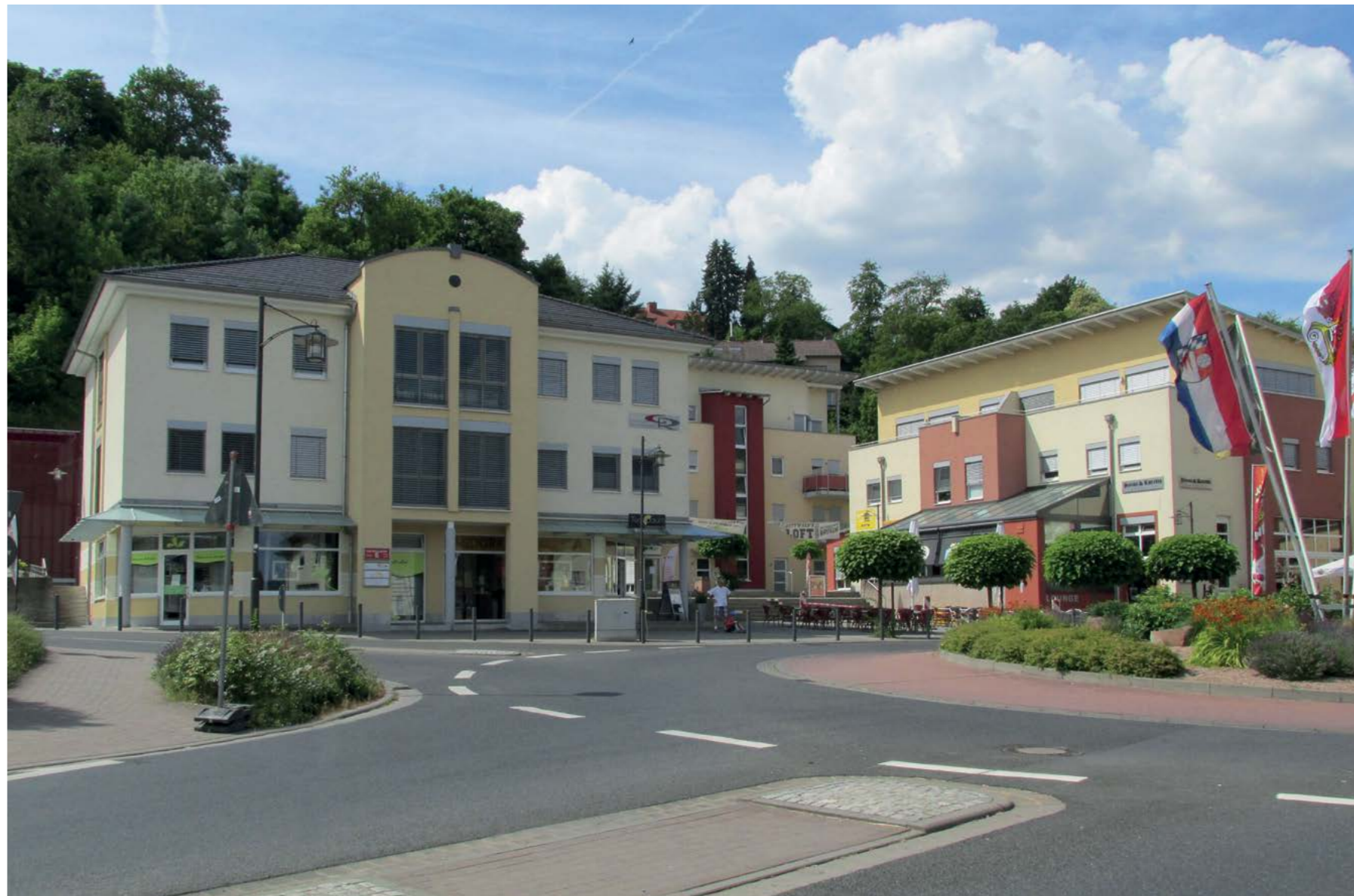
Obernburg, „Sorglos Wohnen“: Erstellung von Wohn- und Gewerbeflächen 45
